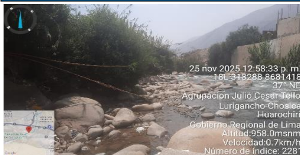
Figura N° 1. Se observa tramo crítico del sector Tramo 6, en la margen izquierda, del Río Santa Eulalia, no cuenta con una protección adecuada para caudales de maximas avenidas
