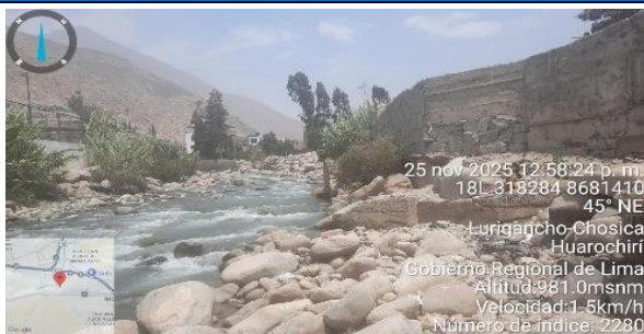
Figura N° 2. Tramo crítico del sector Tramo 6, en la margen izquierda, del Río Santa Eulalia, que existe un pequeño tramo con muro de concreto armado pero de una vivienda, mas no existe protección en todo el tramo de la margen izquierda en dicho
